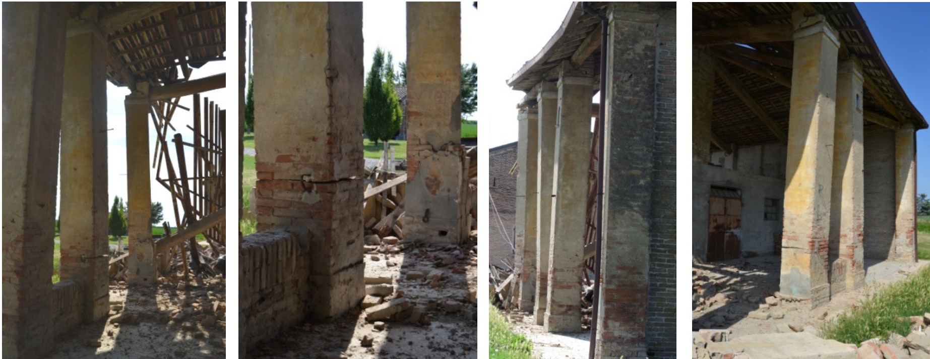
Esempi di rotazioni con parzializzazione alla base dei pilastri del prospetto principale
